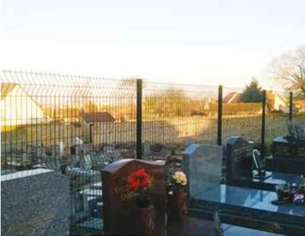
Rénovation complète du mur de séparation avec la partie basse du cimetière. Création d'une base en béton et pose de grillage. Il est prévu un pare-vue de couleur verte apposé au grillage.
